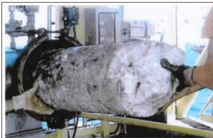
Газогидратная пробка в трубопроводе
